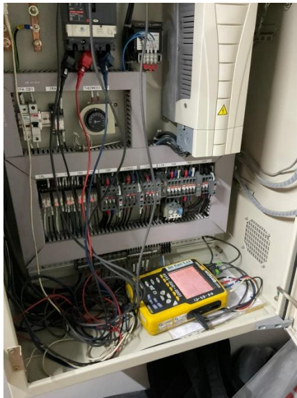
รูปที่ 5-1 การติดตั้งเครื่องมือวัด
